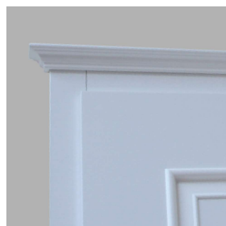
Ozdobná rampa k zárubni (na nadpraží zárubně)
