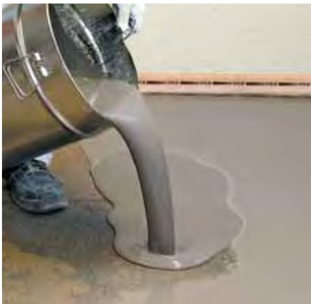
Rychlá stěrka SSP 33 se vylije na připravený podklad.
