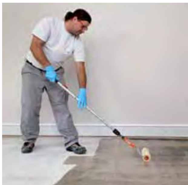
Při nanášení se musí nátěr rozetřít do souvislé vrstvy bez tvorby louží.
