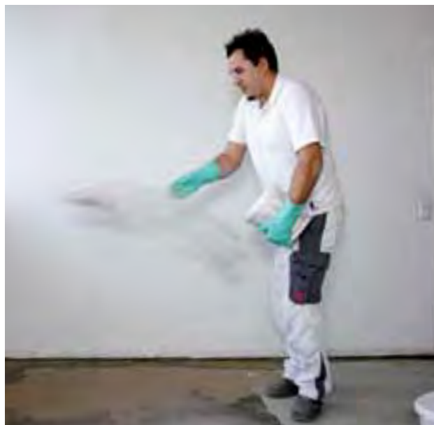
Následně se čerstvě nanesený nátěr zasype křemičitým pískem pro dosažení dokonalého spojení mezi potěrem a samonivelační stěrkou.
