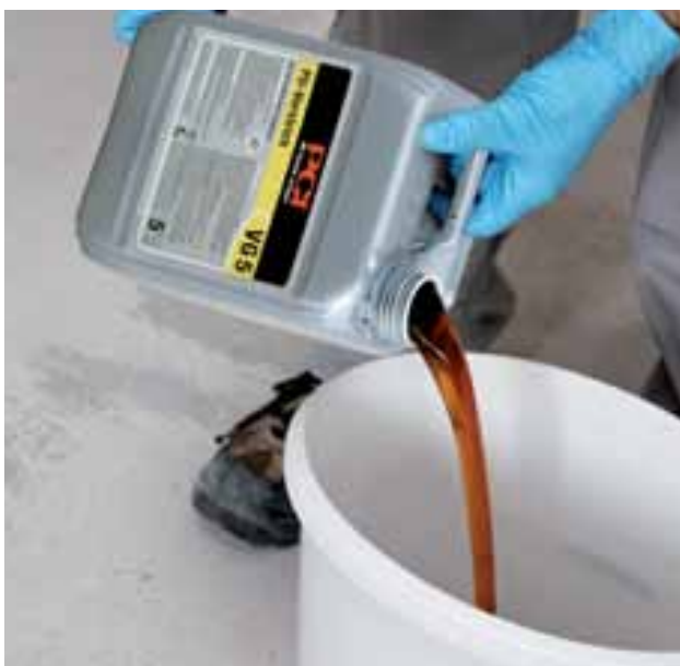
1K PU penetrační nátěr VG 5 se před použitím nechá řádně aklimatizovat na teplotu interiéru.
