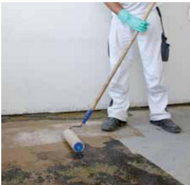
Pro dosažení uzavření zbytkové vlhkosti v podkladu je nutné aplikovat 1K PU penetrační nátěr VG 5 ve dvou nátěrech.
