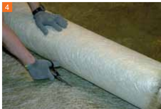
4 Zařezávání Armovací vložky GFM pomocí nůžek.
