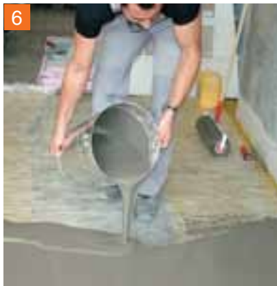
6 Aplikace vhodné PCI samonivelační stěrky v tloušťce min. 5 mm.
