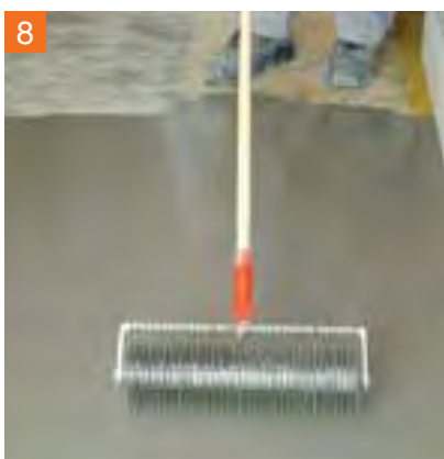
8 Odvzdušnění PCI samonivelační stěrky pomocí ježkového válečku.
