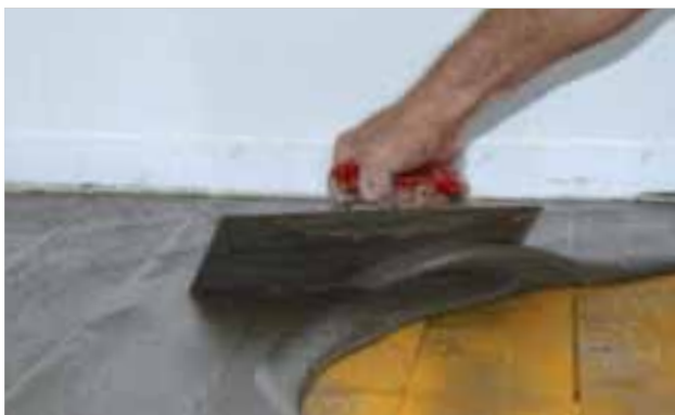
Po smíchání Multi-penetračního nátěru VG 4 a Opravné stěrky lehčené STL 39 se výsledná hmota nanáší hladítkem přímo na podklad.
