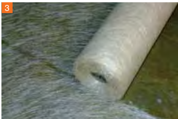
3 Položení Armovací vložky GFM na podklad penetrovaný Multi-penetračním nátěrem VG 4.
