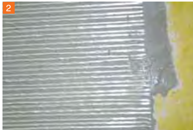
2 Položená Sešivací vložka GFS po odstranění nosné fólie.
