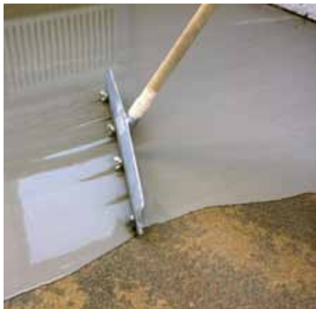
Následně se pomocí rakle rozetře do potřebných tlouštěk.
