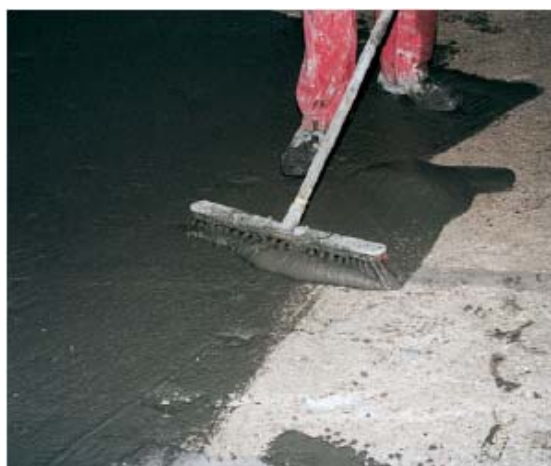
Spojovací můstek PCI Repahaft® se kartáčem nanese na připravený podklad. Malty a potěry se nanášejí do čerstvého spojovacího můstku.
