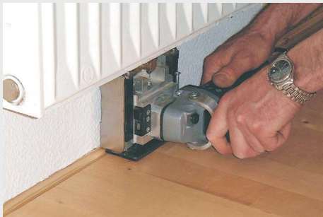
Řezání dilatačních spár pod radiátory
